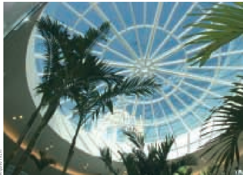
Cúpula do Ribeirão Shopping: luz natural reduz o consumo de energia
